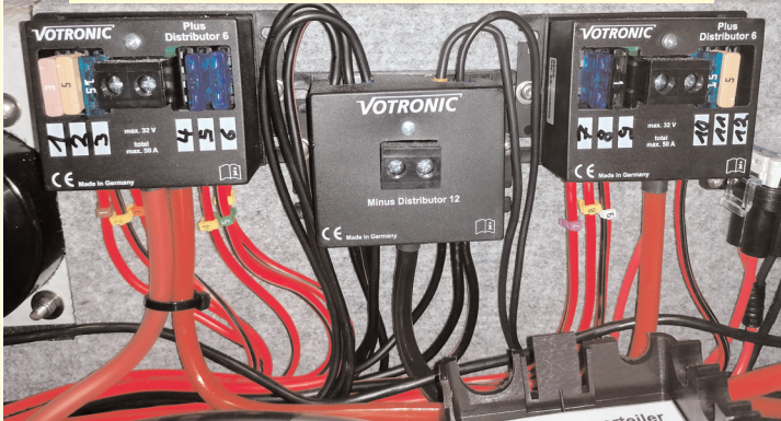
Größer Sicherungsverteiler
